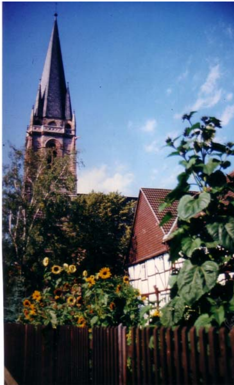
Kirchturm und ehemaliges Pfarrhaus (vor dem Umbau in 2001)
